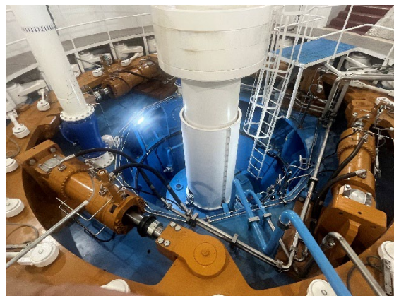
Turbinenschacht nach Überholung Copyright: ANDRITZ
